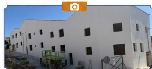
Avance de obras en calle Jaén.
