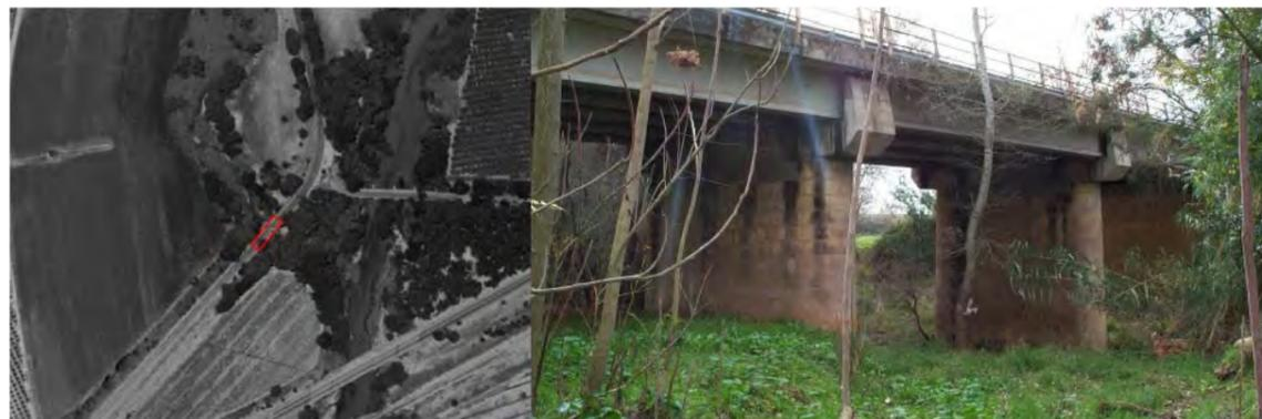
DESCRIPCIÓN: Puente carretero de hormigón tipo viga que estaba compuesto por tres tramos de vigas de hormigón armado sobre pilas de mampostería con tajamares semicilíndricos de sillería. Rematan las pilas en unos balconcillos que nacen en la calzada; tiene barandilla metálica de hormigón. Medidas: Longitud total: 44 m. Altura máxima rasante: 11,5 m. Espesor de las pilas: 1'6 m. Luz libre: 13 m. Anchura tablero: 6,25 m.
