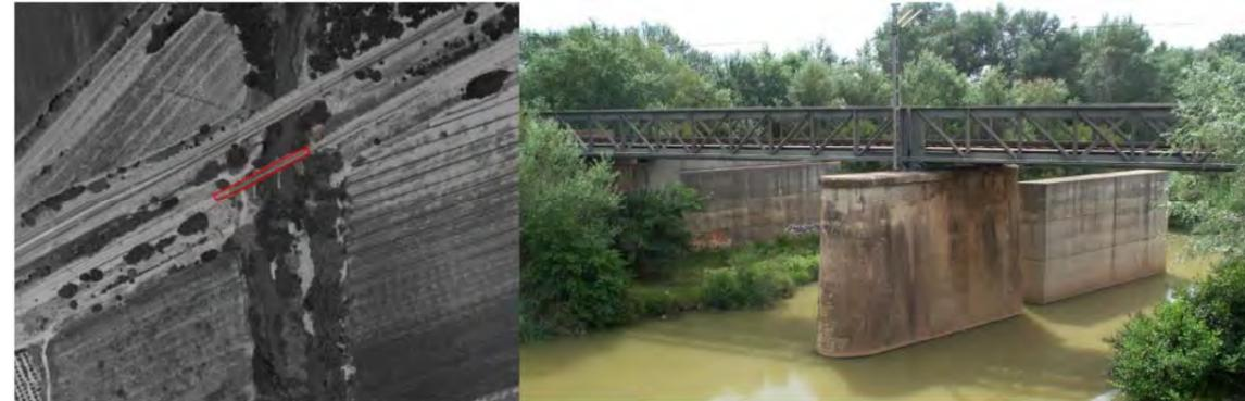
**DESCRIPCIÓN:** Puente de ferrocarril metálico tipo celosía, compuesto por tres ramos metálicos con vigas tipo "Pratt" sobre pilas de sillares de forma y posición irregular.
